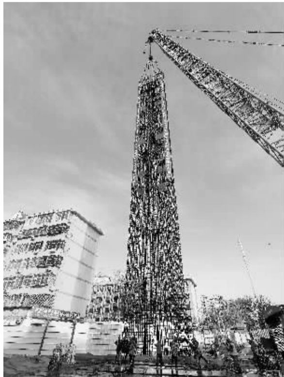
■最后一幅地连墙钢筋笼入槽。
