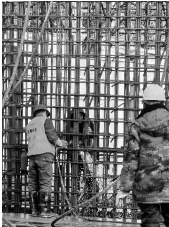
■建设者切割钢筋笼多余钢筋。
