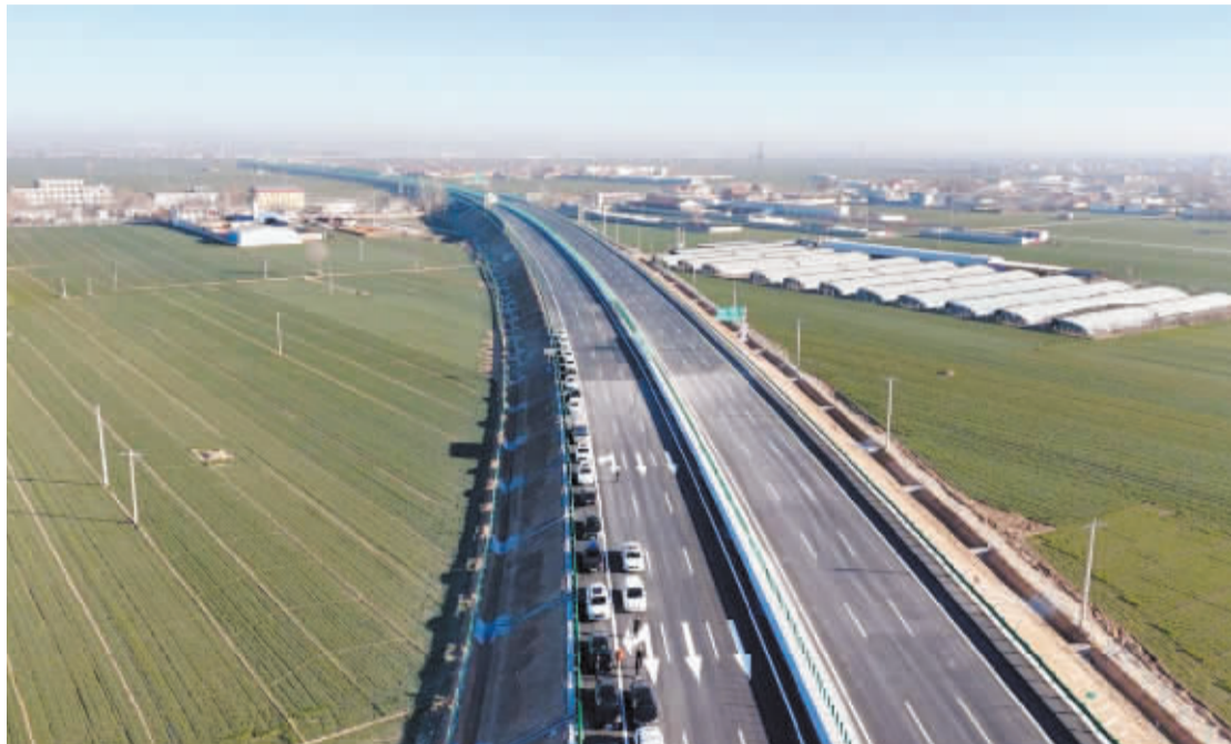
■衡昔高速公路通车路段,采用双向六车道高速公路标准。(交投集团供图)
