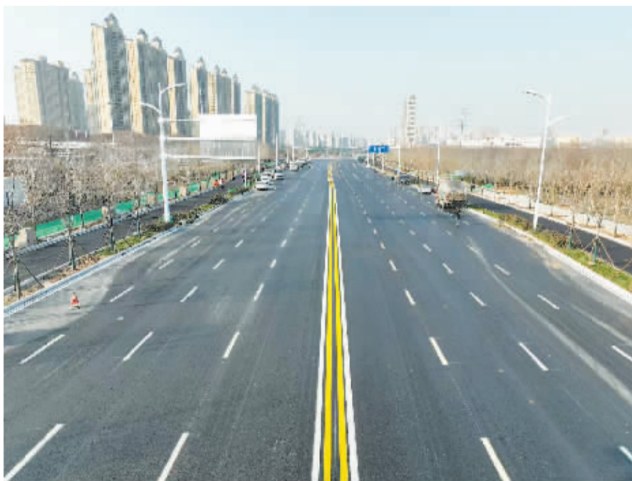
■仓盛路(颂扬大街-复兴大街)设计速度为50公里每小时,双向6车道。这是昨日下午拍摄的通车前画面。(城发投集团供图)
