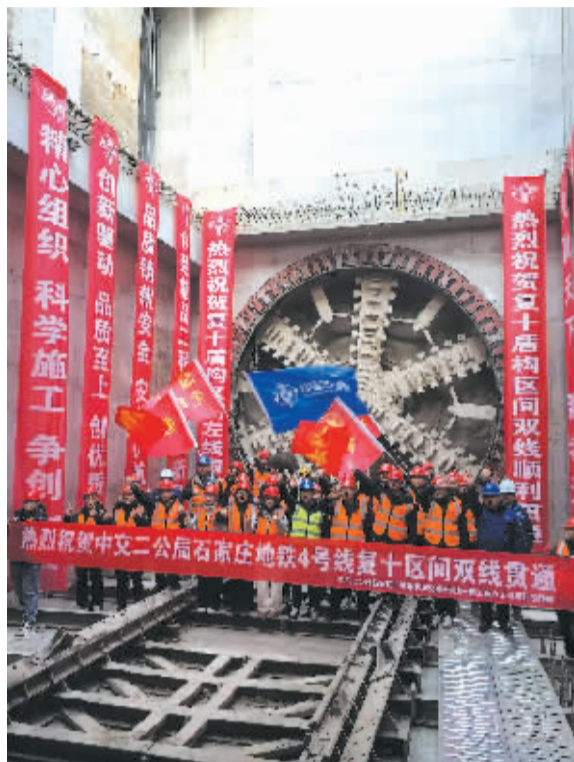
■地铁4号线最长区间双线贯通。
