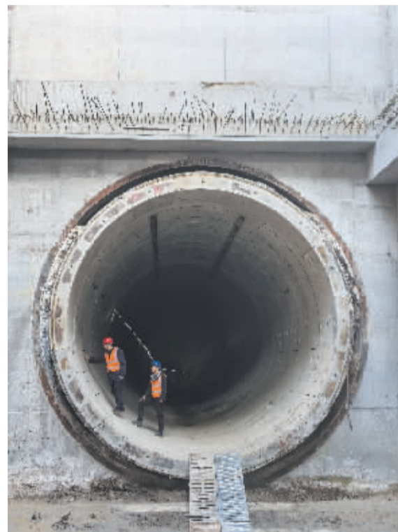
■在贯通的隧道内,工作人员正在进行巡检。
