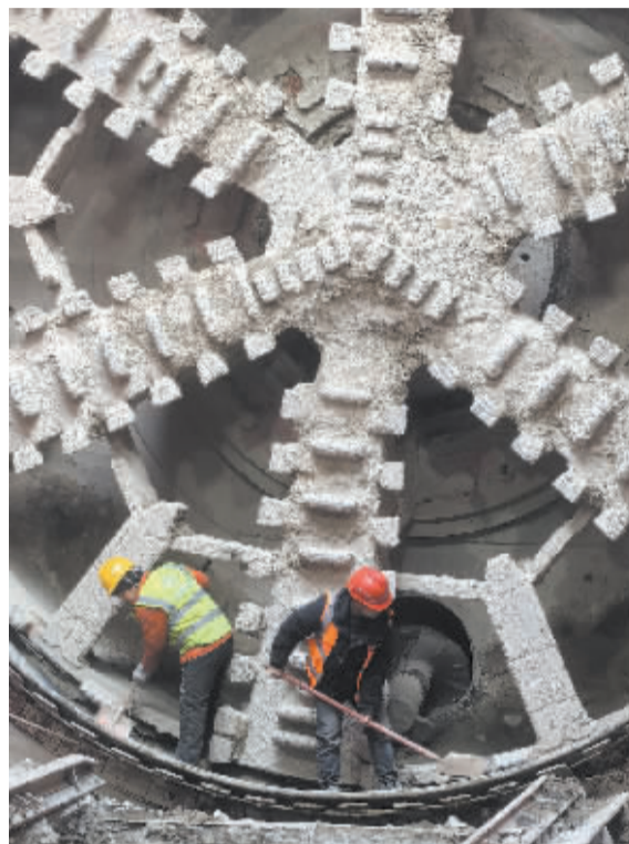
■建设者清除刀盘上的渣土。
