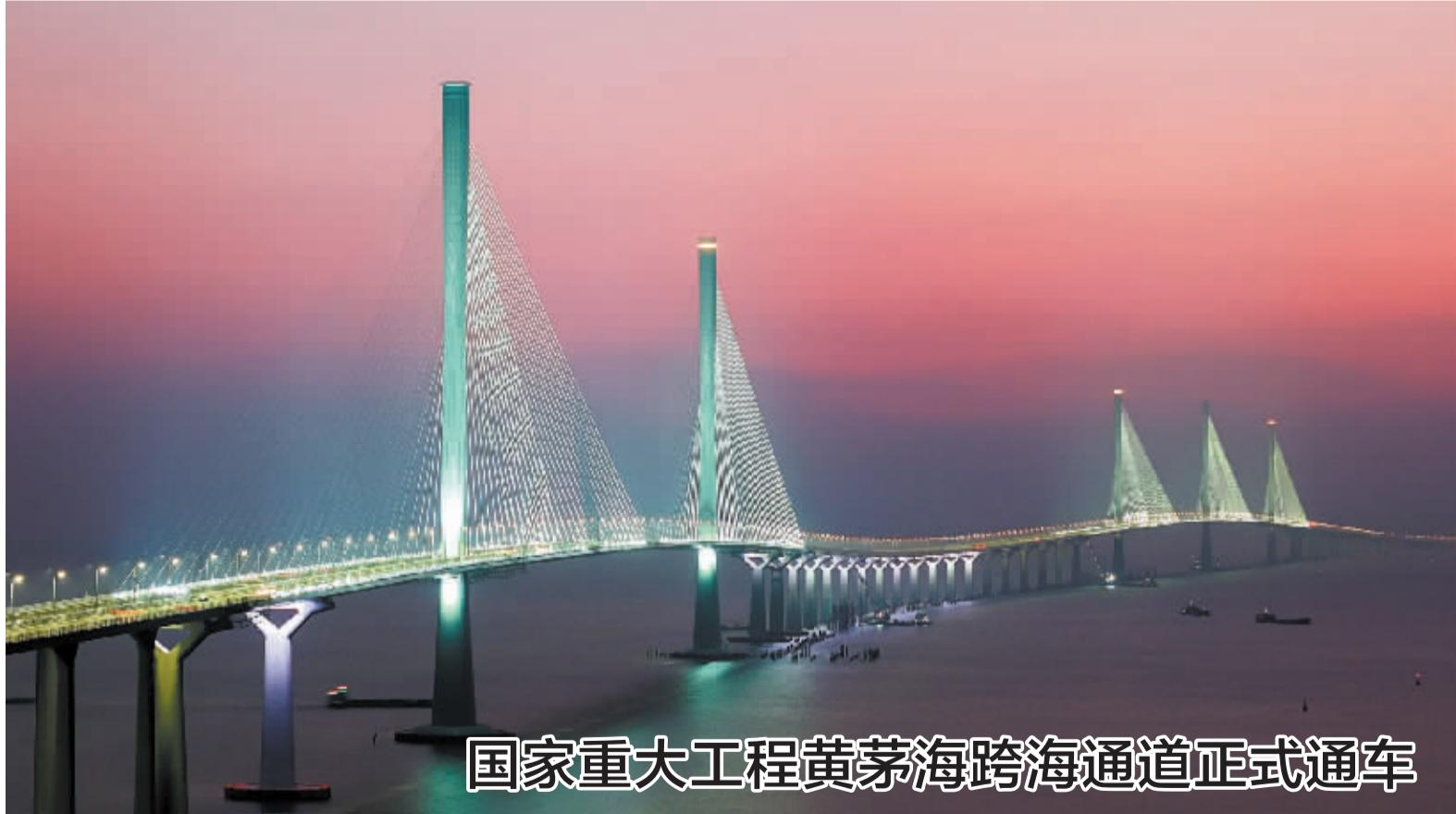
■暮色中的高栏港大桥(左侧双主塔)和黄茅海大桥(右侧三主塔)(12月7日摄,无人机照片)。12月11日,由广东交通集团建设管理,保利长大、中交路建、中铁大桥局、中铁十一局等30多家单位建设的国家重大工程黄茅海跨海通道正式通车。黄茅海跨海通道于2020年6月开工建设,是《粤港澳大湾区发展规划纲要》发布后首个开工的跨海通道工程,也是继港珠澳大桥、深中通道之后大湾区又一跨海通道重大工程。黄茅海跨海通道采用双向六车道高速公路标准,设计时速100公里。项目起于珠海市平沙镇,终于江门市台山市斗山镇,全长约31公里。其中,跨海段长度约14公里,设置高栏港大桥、黄茅海大桥两座主桥。
