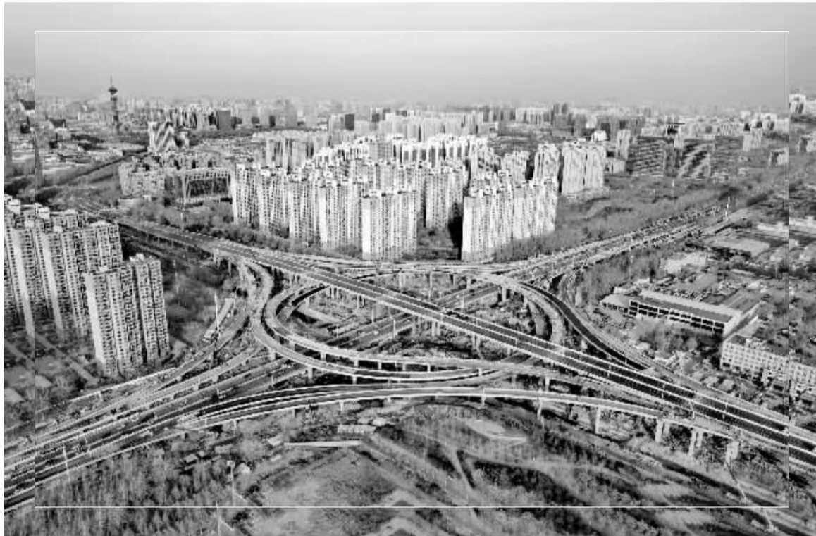
■裕翔街快速连通工程南二环立交桥。
