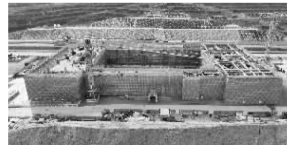
■雄忻高铁阜平站建设现场。(中国铁路北京局供图)
