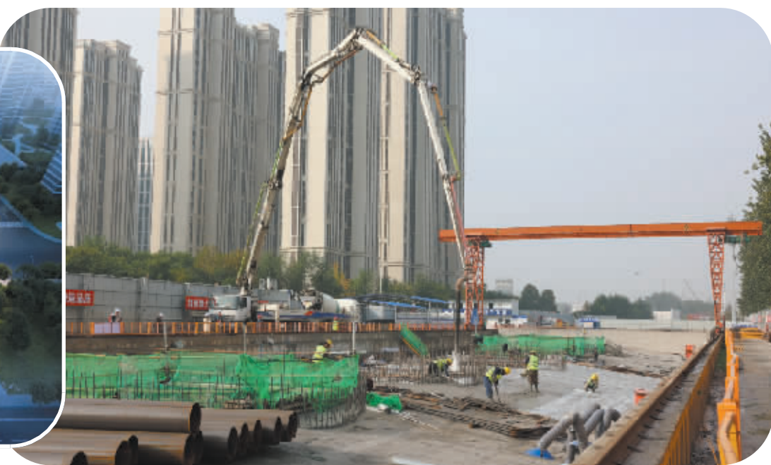
■体育公园站最后一块顶板浇筑中。
