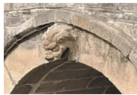
■正定广济桥桥拱。
