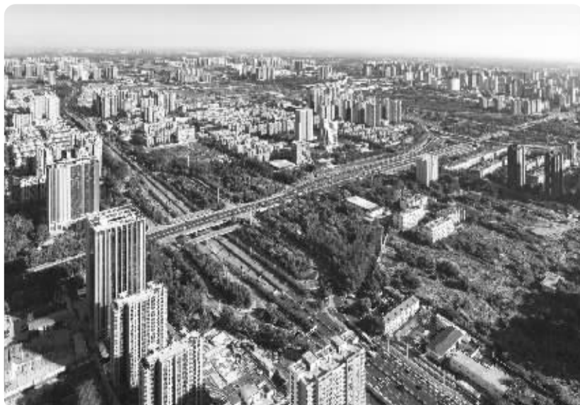
■今年拍摄的东二环裕华路立交桥。
