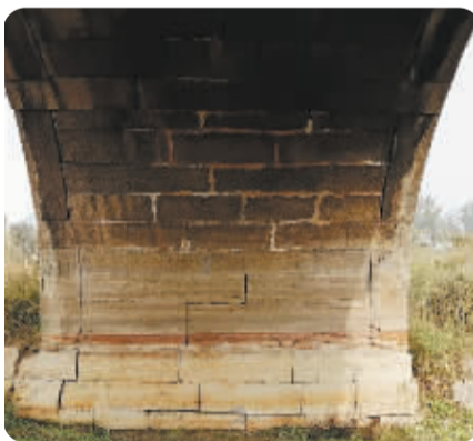
■深泽永济桥拱券内部。
