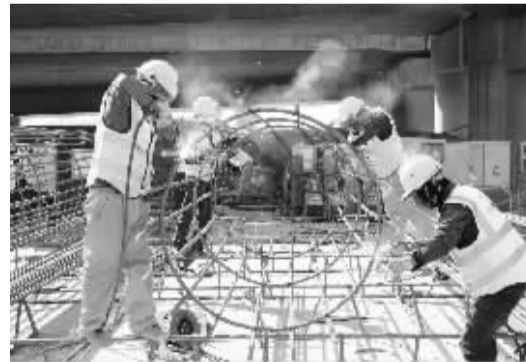
■复兴大街南二环匝道施工第二天。于志高 摄
