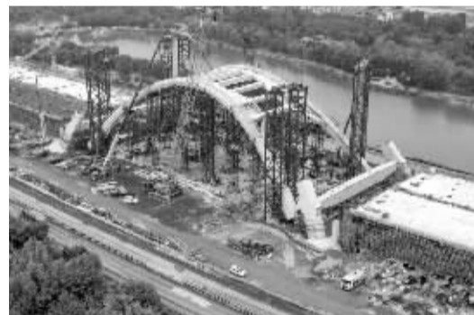
■建设中的泊水桥。于志高 摄
