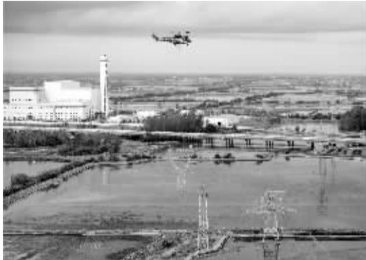
江苏兴化:直升机吊运助力铁塔架设
