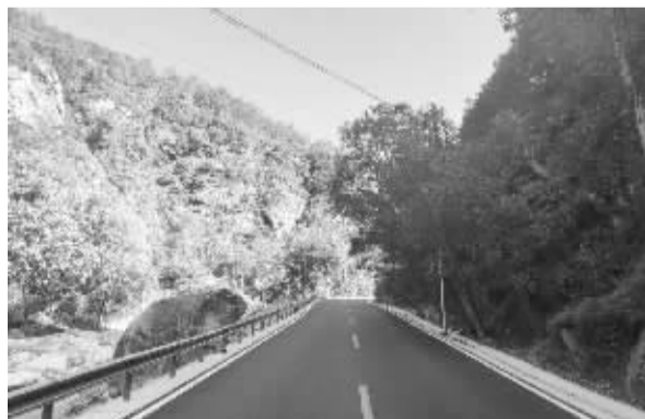
■平山县县道木下线合河口至小觉段农村公路灾毁提升工程竣工通车。 通讯员 王涛 杜昱 摄
