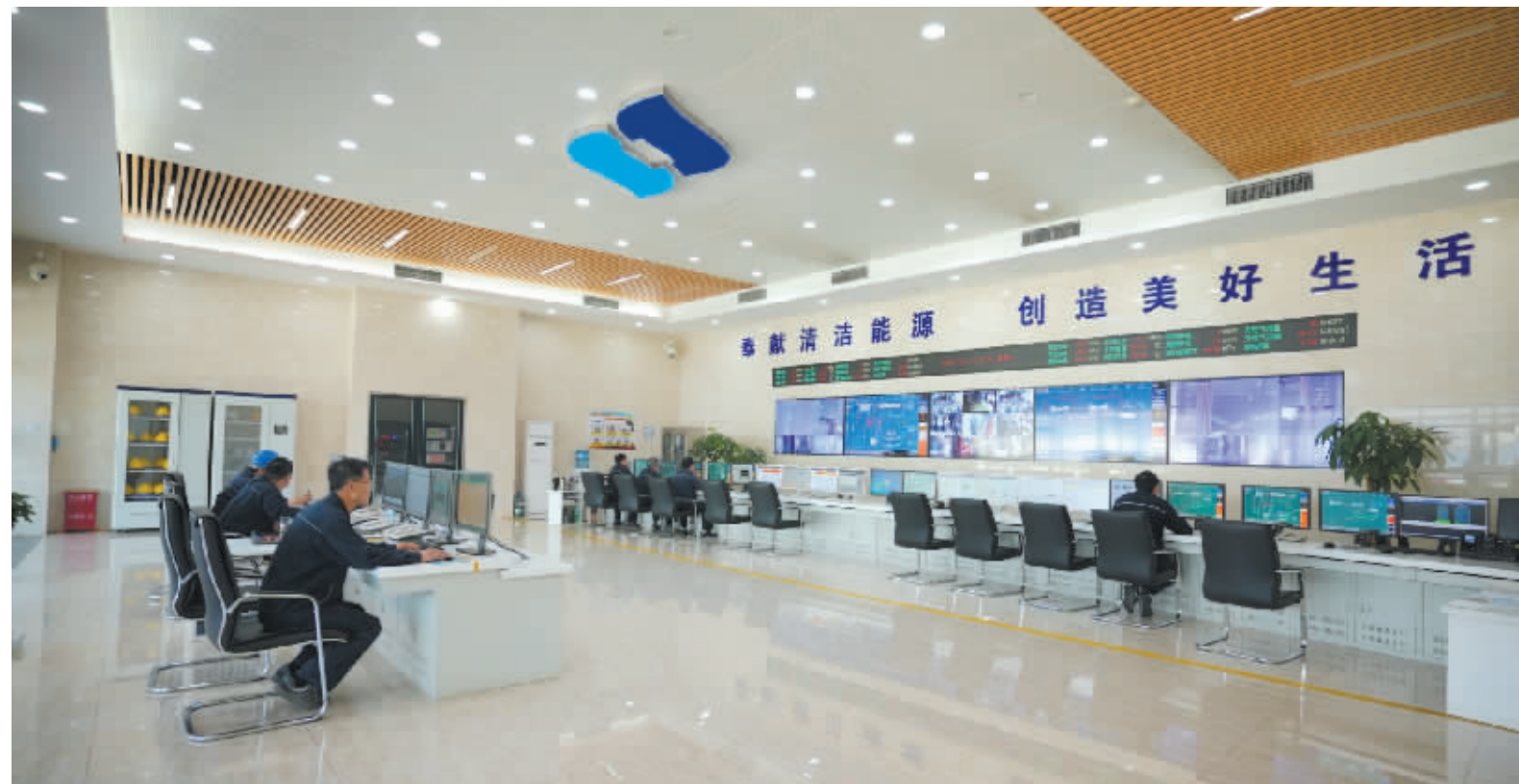
■九期燃机集控室。
