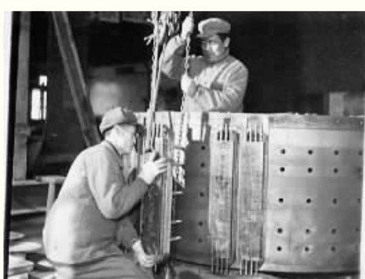
■安装发电机转子。
