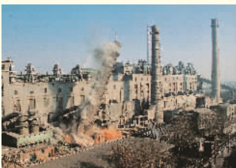
■为了响应国家节能减排号召,于 2002 年 11 月 25 日采用定向爆破拆除了 1 号烟囱。
