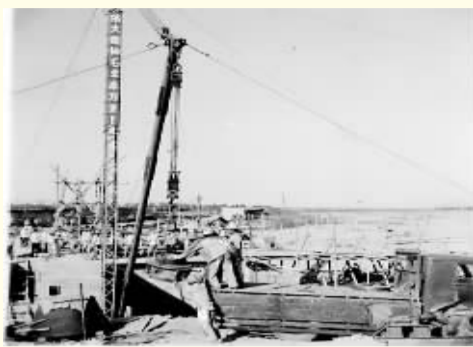
■在岗南水库安装水电站现场。
