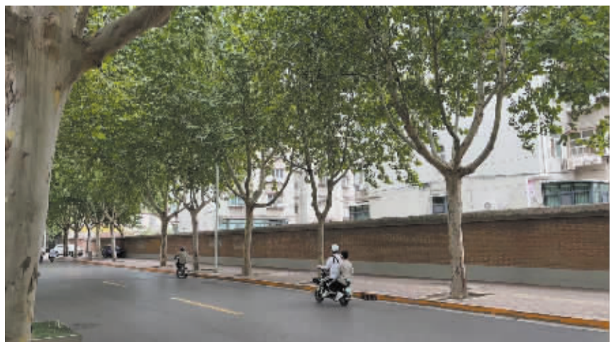
■提升改造前的文苑街墙面较为破旧。(街道供图)
