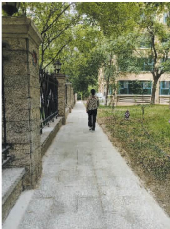
■鹅卵石路面改造为平整的地砖路面。
