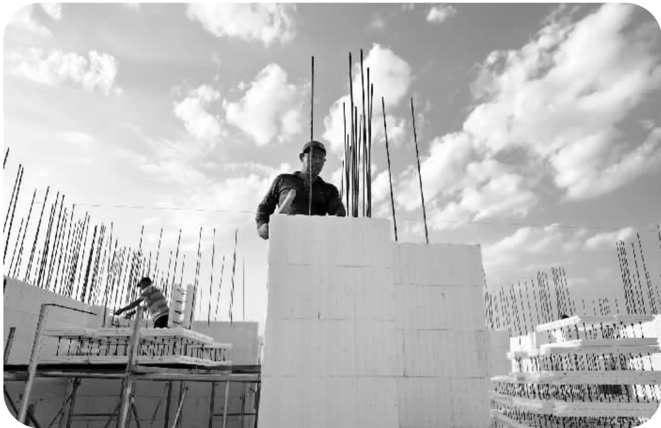
■建设中的装配式农房。(资料图片)
