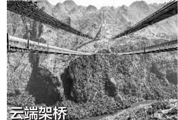
■这是建设中的花江峡谷大桥(9 月 3 日摄)。花江峡谷大桥是贵州省六枝至安龙高速公路的关键控制性工程, 于 2022 年开工建设, 预计 2025 年建成。大桥为钢桁梁悬索桥, 全长 2890 米、主跨 1420 米, 桥面距水面垂直高度 625 米, 建成后将超越杭瑞高速公路上的北盘江大桥, 成为世界第一高桥。近日, 建筑工人在距离江面 600 至 700 米的高空作业, 如同云端架桥。
