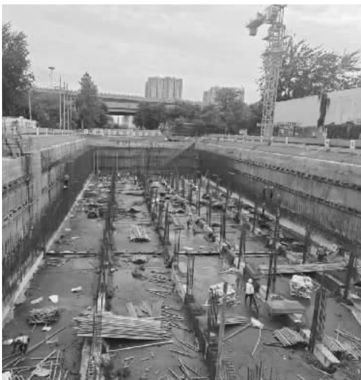
■石铜路雨水调蓄工程建设现场。(石市城管局供图)
