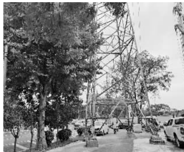
改造完成后,“铁塔拦路”现象将消失。
