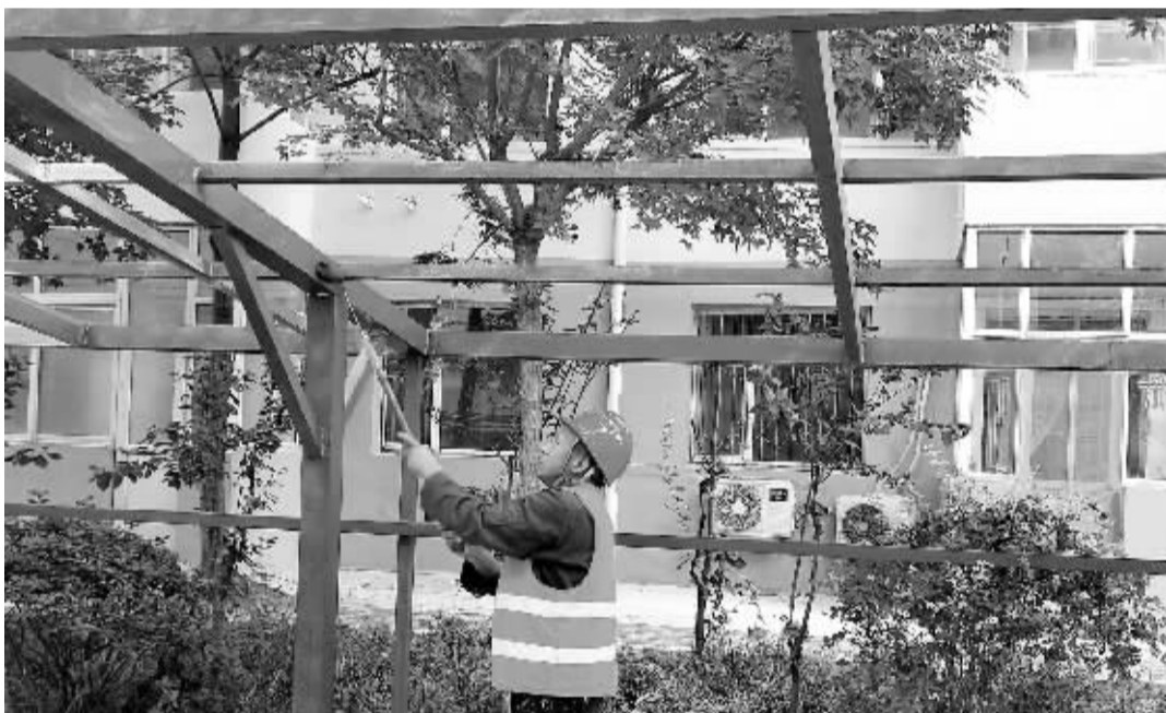
■图为8月27日,在新华区某老旧小区改造现场,施工人员正在粉刷车棚架。石家庄日报记者 宋钧 摄
