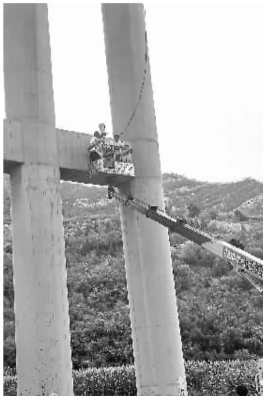
■平赞高速金良河大桥视频监控预警系统设备安装现场。
