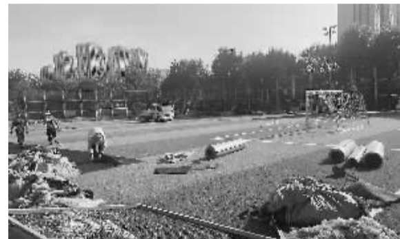
■工作人员对2号地七人制足球场进行提升改造。(体育公园供图)
