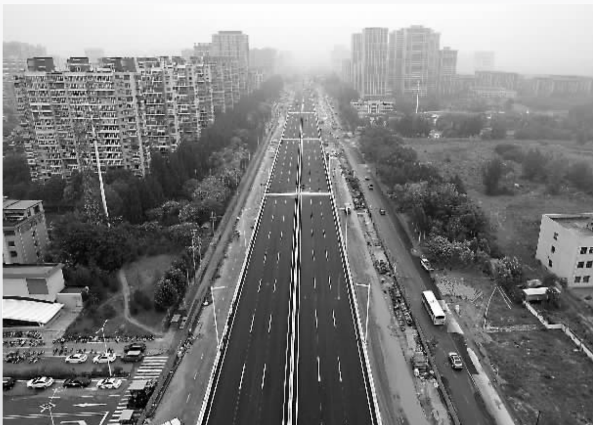
■东二环改造工程南起南二环北至裕华路立交桥南侧。
