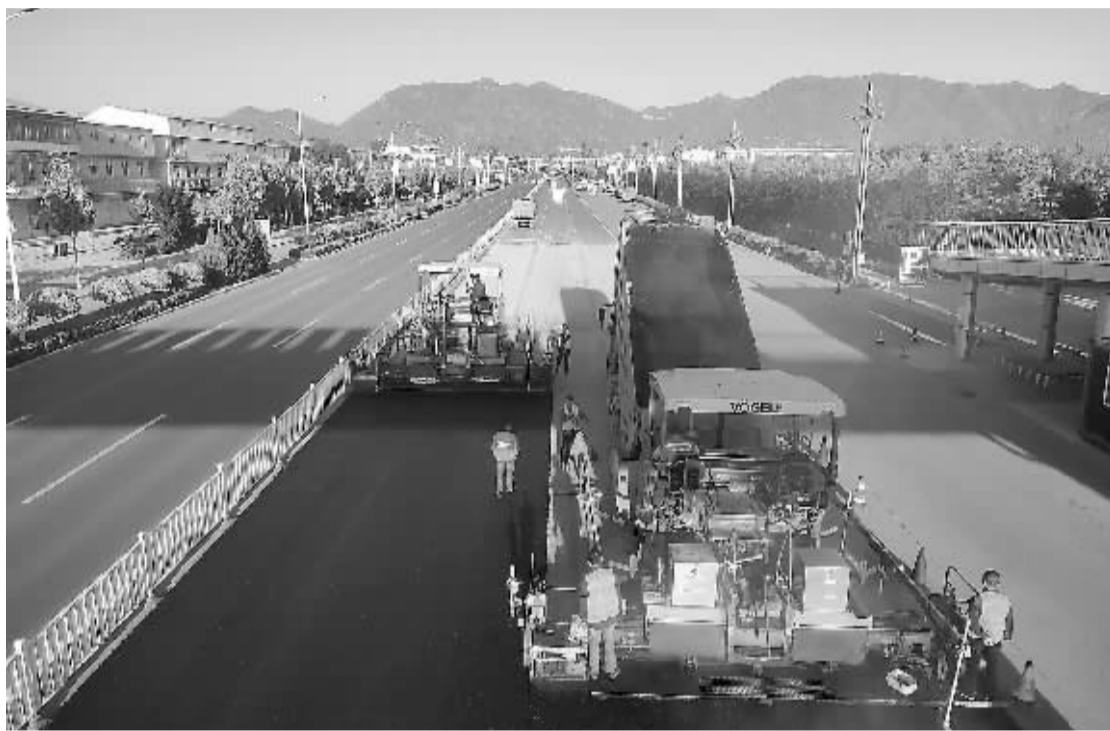
■省道S537南二环西延段大修铺油。(石市交通运输局公路服务保障中心供图)
