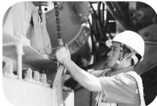
■建设者正在进行最后的设备调试。
