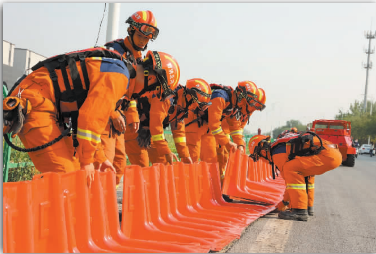
■参加演练人员安装挡水板。
