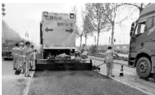
■国道G307藁城区段进行热再生养护作业。(通讯员 高亚欣 张玉红 供图)
