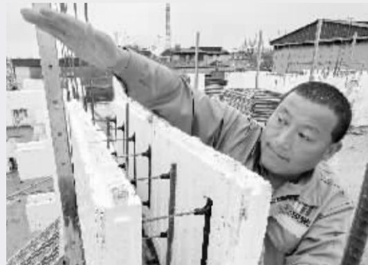
■用EPS挤塑板建的房子保温、隔音、防潮还抗震。
