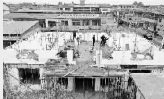
■施工中的装配式农村住宅。
