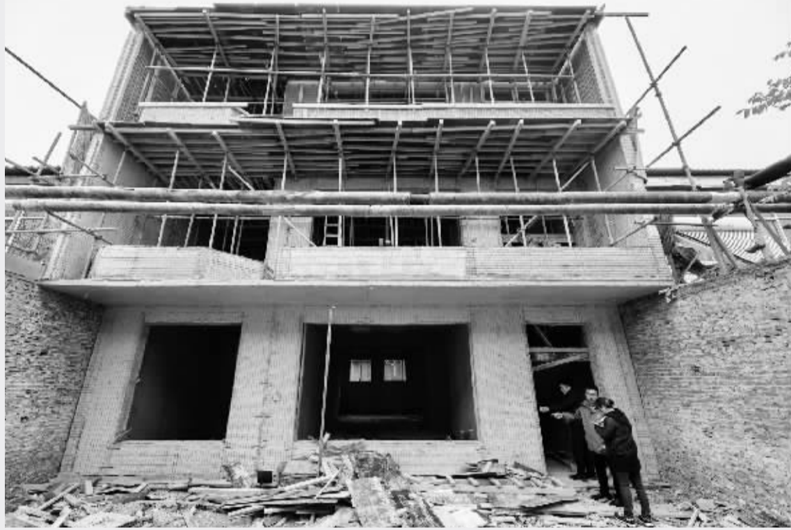
■这栋三层小楼主体完工仅用20天时间。
