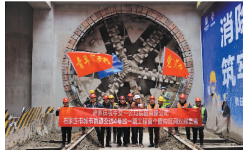
■地铁4号线一期工程首个区间隧道双线贯通。
