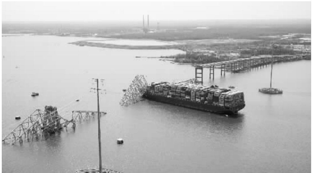
■ 3月26日拍摄的遭撞击后坍塌的“弗朗西斯·斯科特·基”大桥和撞击大桥的集装箱船。 新华社发
