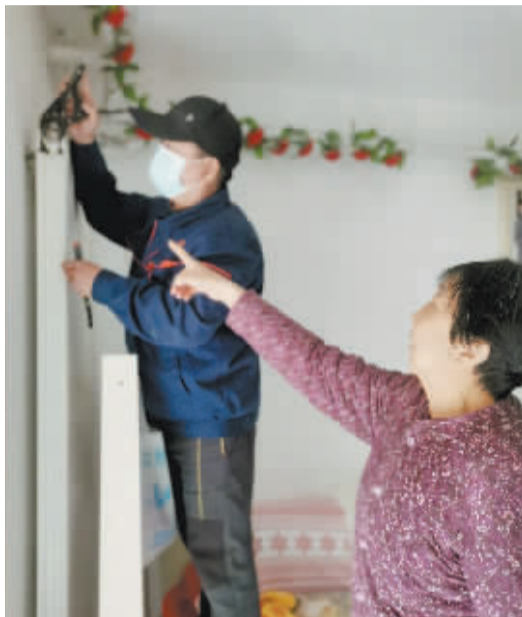
■工作人员在对供热设施进行检修。
