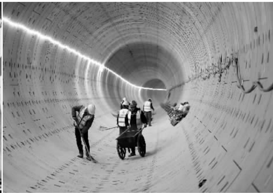
■建设者在刚贯通的隧道内作业。本报记者 张海强 摄
