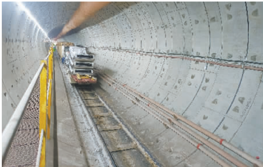
■工程车正在运送管片。本报记者 冯月静 摄
