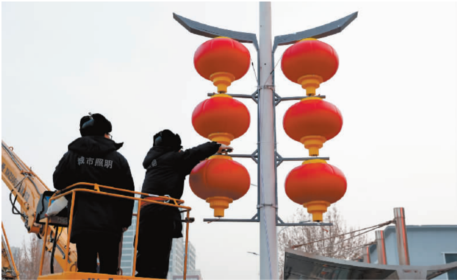
■城市照明管护中心的工作人员正在安装灯笼。
