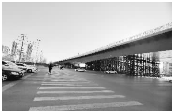
■南二环(仙台街-太行大街)快速连通工程跨太行大街段施工现场 通讯员 卢颖 摄
