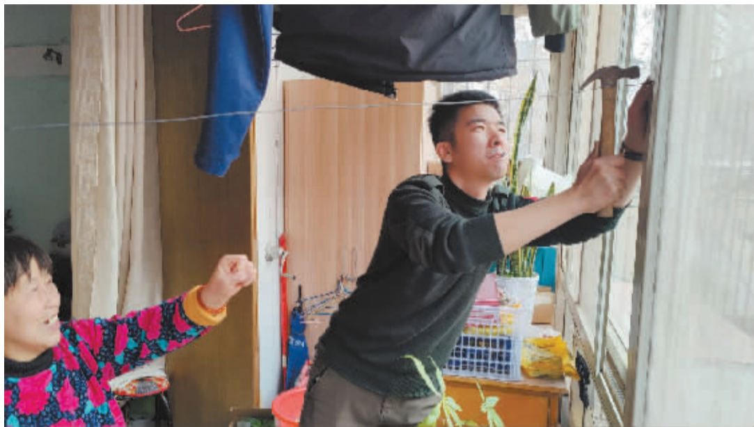
■热心肠的张增涛入户为居民加固窗户。 本报首席记者 杜慧 摄
