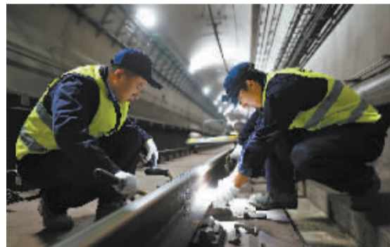
■轨道巡检工使用专业工具调整轨道高低。
