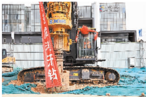
■石家庄地铁5号线光华路站首桩开钻。
