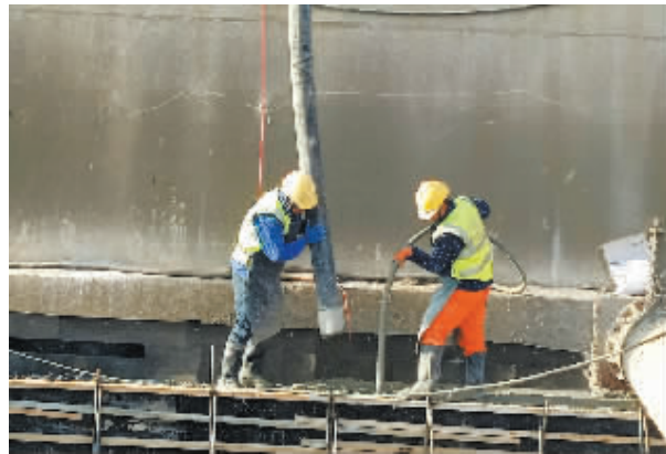
■石家庄地铁4号线石铜路站封顶施工。
