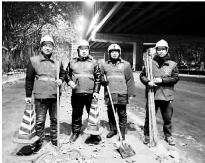
■河北爱心救援队志愿者清除高架桥下的冰锥。
