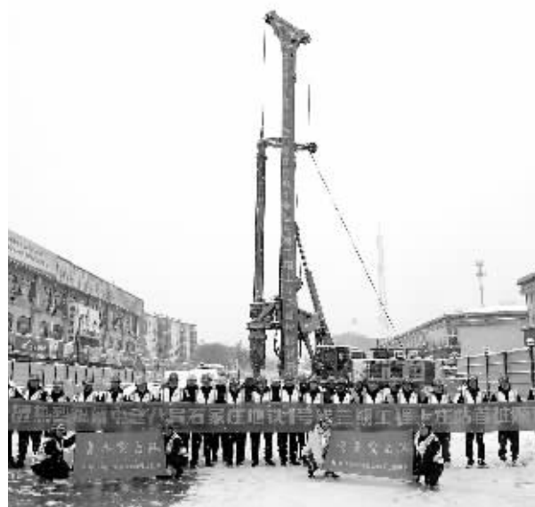
■15日上午,地铁1号线三期工程在上庄站打下第一桩。本报记者 张海强 摄
