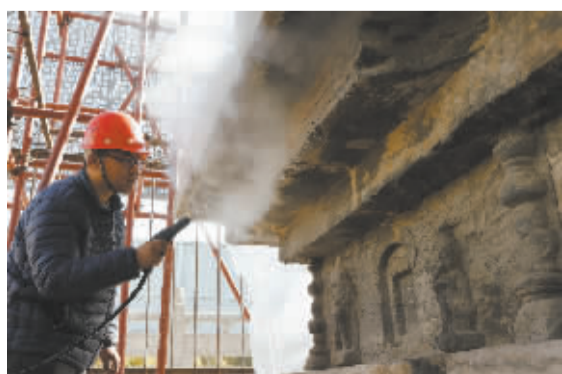
■使用高压蒸汽机对岩石表层进行清理。
