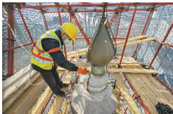
■工作人员正在清理塔尖。
