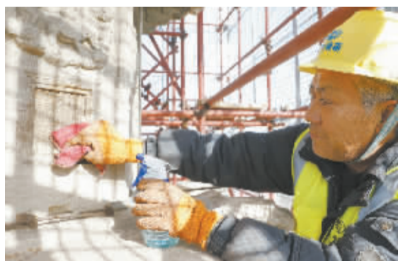
■工作人员在塔顶部做表层污染清理工作。
