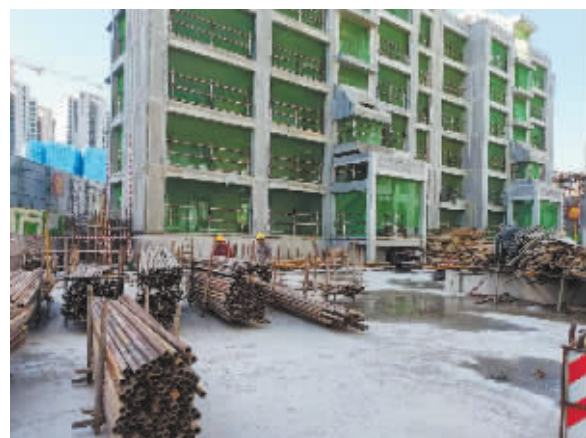
■和平路 26 号院项目加紧建设中。(图片由住建集团提供)
