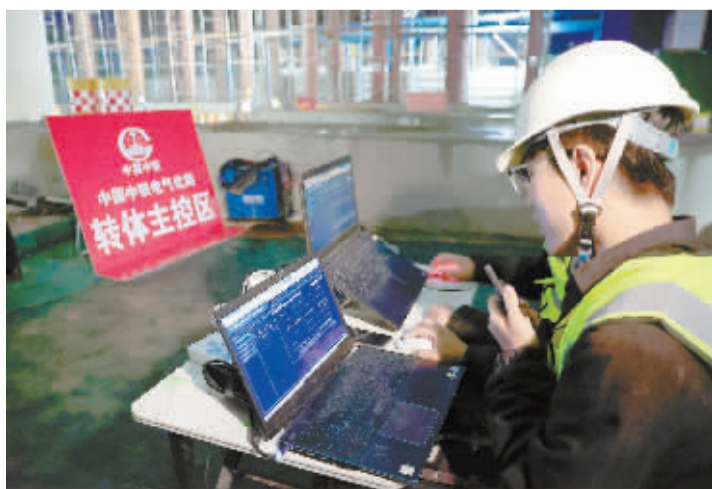
■技术人员正在通过仪器监测桥梁转体时产生的震动。
