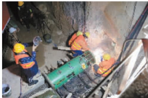
■中铁电气化局施工人员对牵引钢绞线进行切割。
