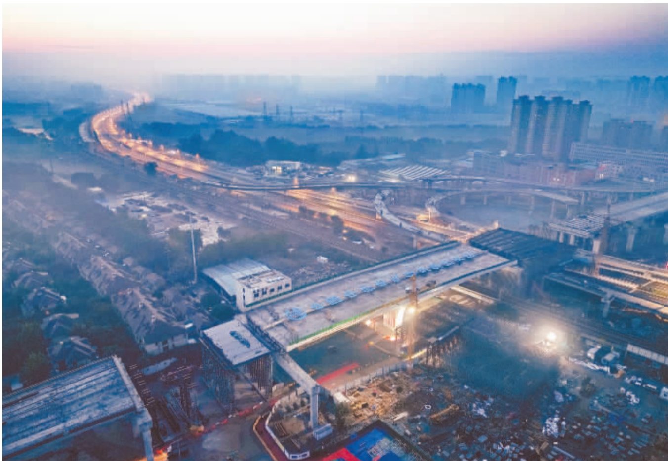
■10月18日凌晨,石家庄市中华大街上跨西环线铁路T型刚构桥成功转体。新华社记者牟宇摄
