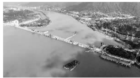
■9月27日拍摄的三峡大坝及三峡电站。
