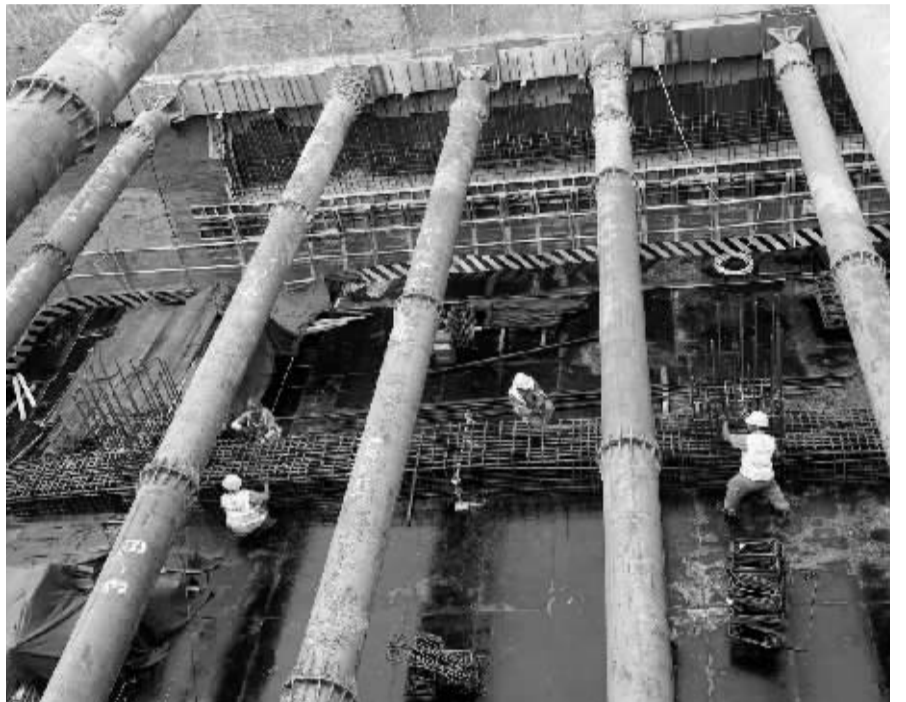
■石铜路站正在加紧建设中。
