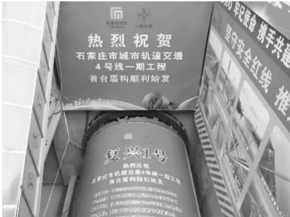
■在石铜路站,地铁4号线一期工程首台盾构始发。
