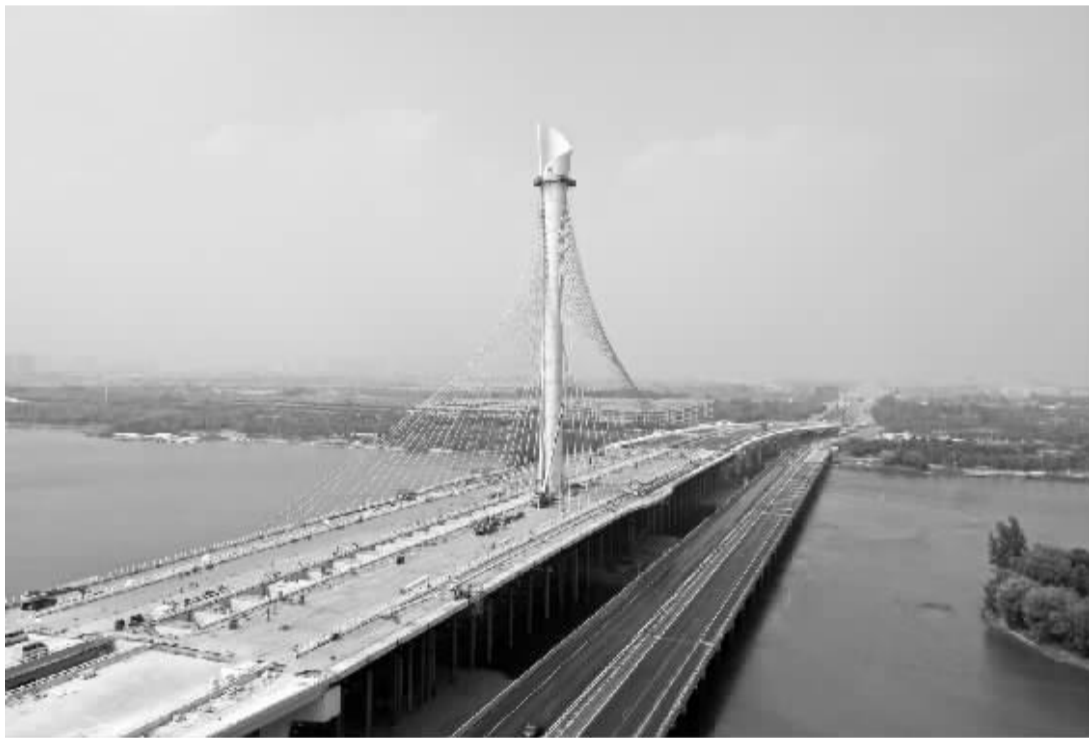
■滹沱河特大桥斜拉索安装完毕雄姿初现。
